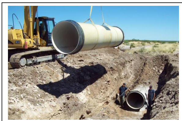
Figura 3.4.3: Instalación de cañería en el Acueducto del Río Colorado
