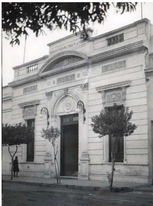
Fachada primer edificio Patria e Lavoro (Archivo Club Italiano)
