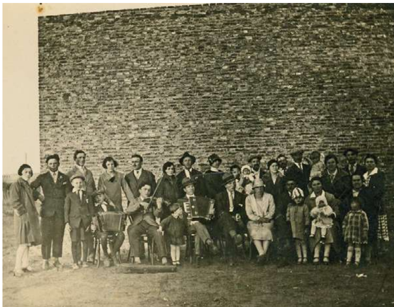
Celebración durante las primeras etapas de la construcción de muros y un pozo artesiano en el frente del futuro edificio de la institución (1912). Fuente: Archivo Club Italiano.
