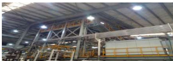
Ilustración 4: Cañería sistema de vacío.
