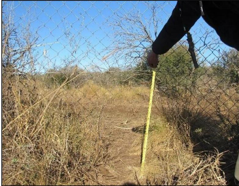
*Figura N°10: Abertura con bordes levantados a más de 0.6 metros con el alambre trenzado y sin aristas.*
