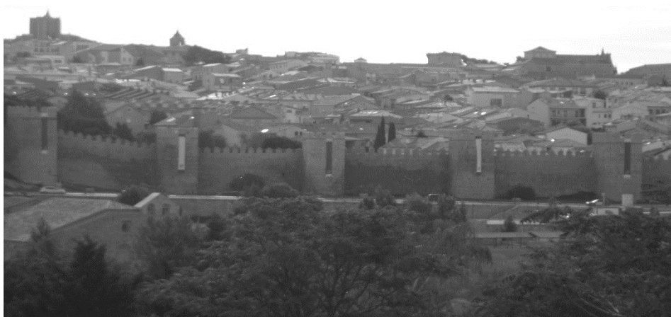
Imagen panorámica de la ciudad de Ávila (España), en la que se destaca al frente la muralla que la rodea.
