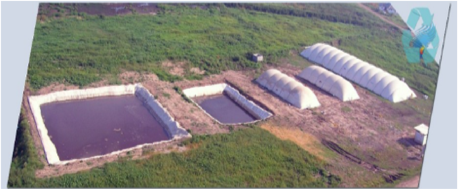
Fotografía 1: Tren Lagunar anaeróbico- facultativo – aeróbico.
