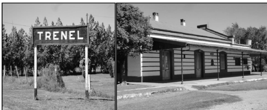
Fotografía N° 8. Trenel. Estación ferroviaria
