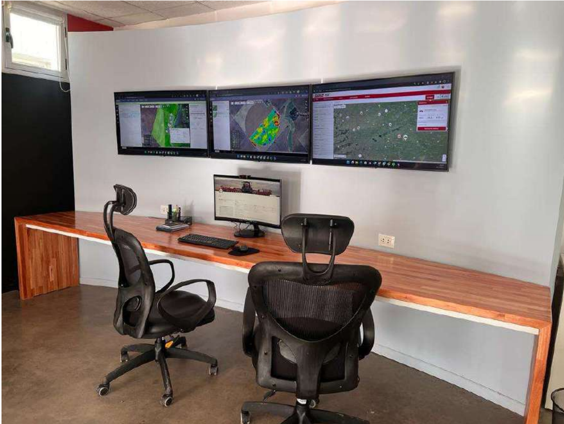
Fotografía 1: Panel curvo con el equipo de monitoreo
