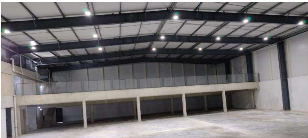
Ilustración 3: Ejemplo de iluminación en galpones
