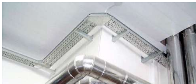
Ilustración 2: Ejemplo de bandejas portacables y ménsulas amuradas
