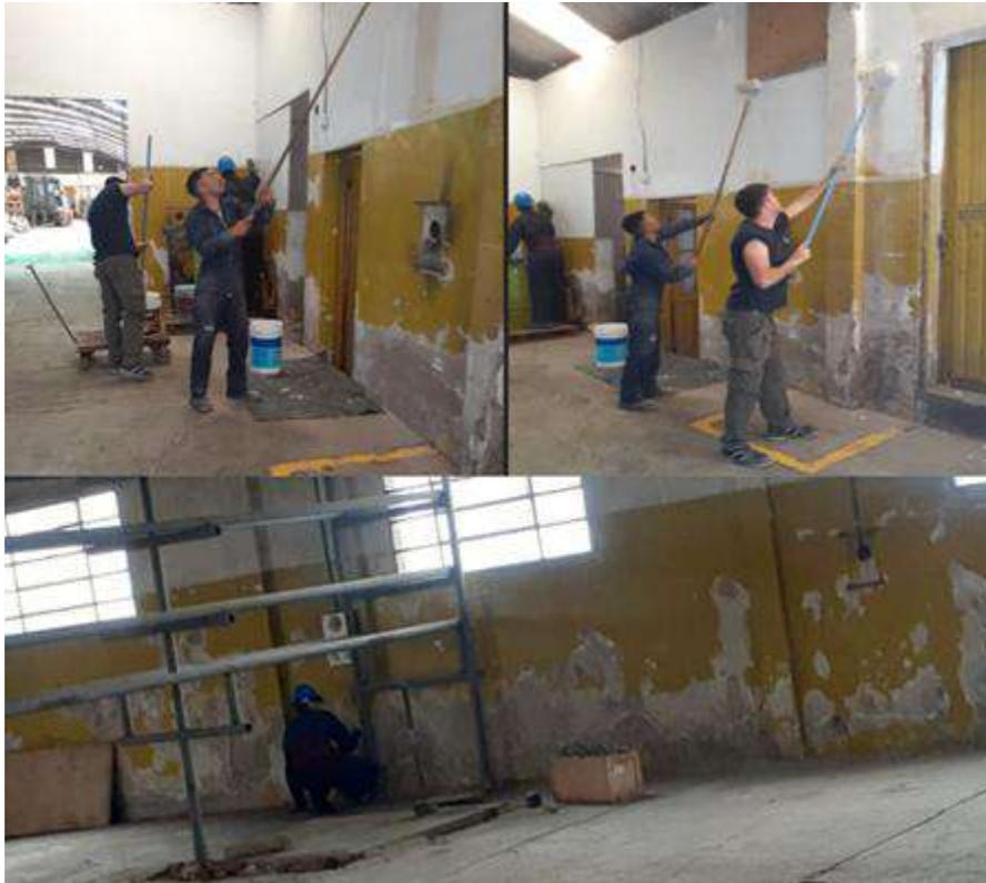
Figura 4.3: Reacondicionado y pintado parcial de paredes.
