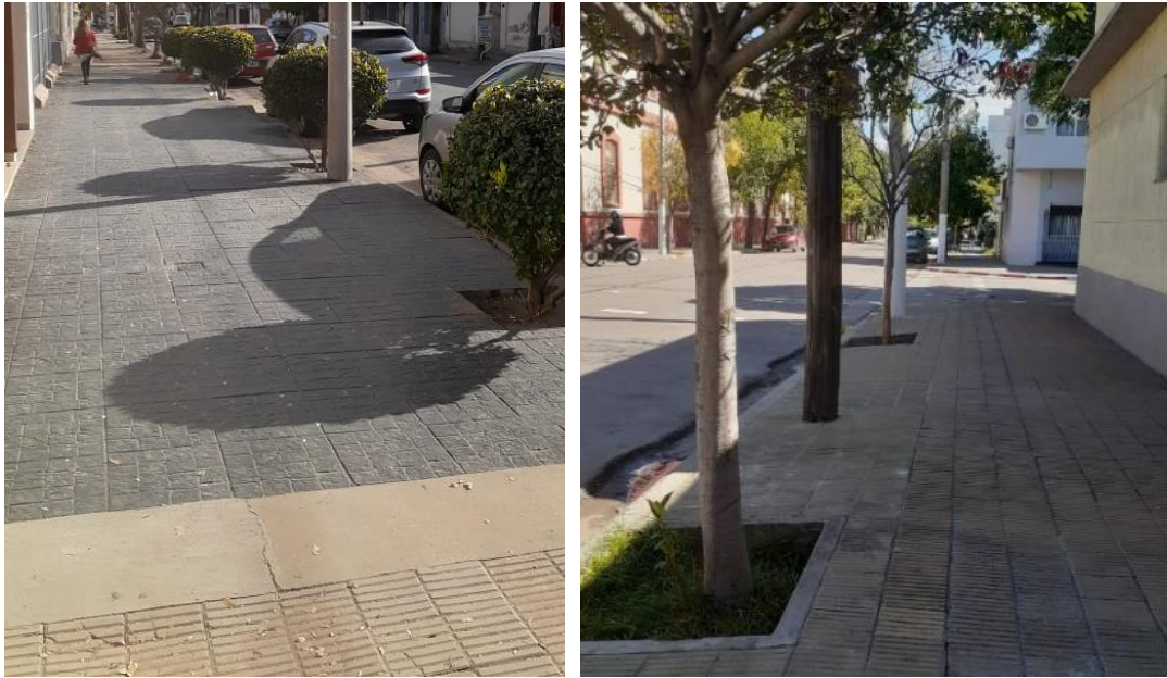
Figura 39. Condición de la vereda: Veredas en buena condición en la zona céntrica de la ciudad de Santa Rosa, La Pampa.
