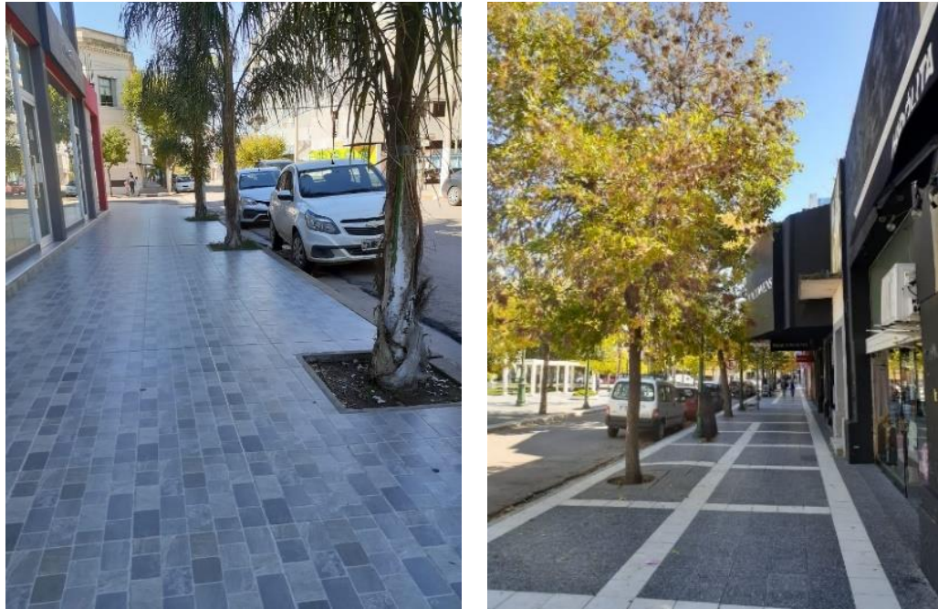
Figura 16: Veredas en condición buena, niveladas y sin deterioro evidente.
