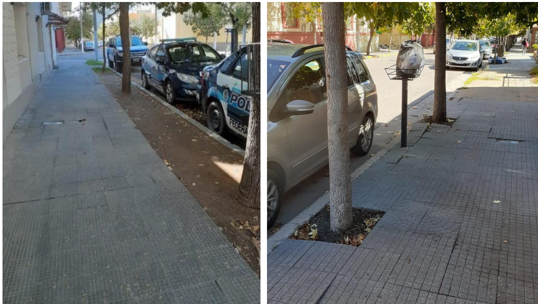
Figura 40. Condición de la vereda: Veredas en una condición regular en la zona céntrica de la ciudad de Santa Rosa, La Pampa.
