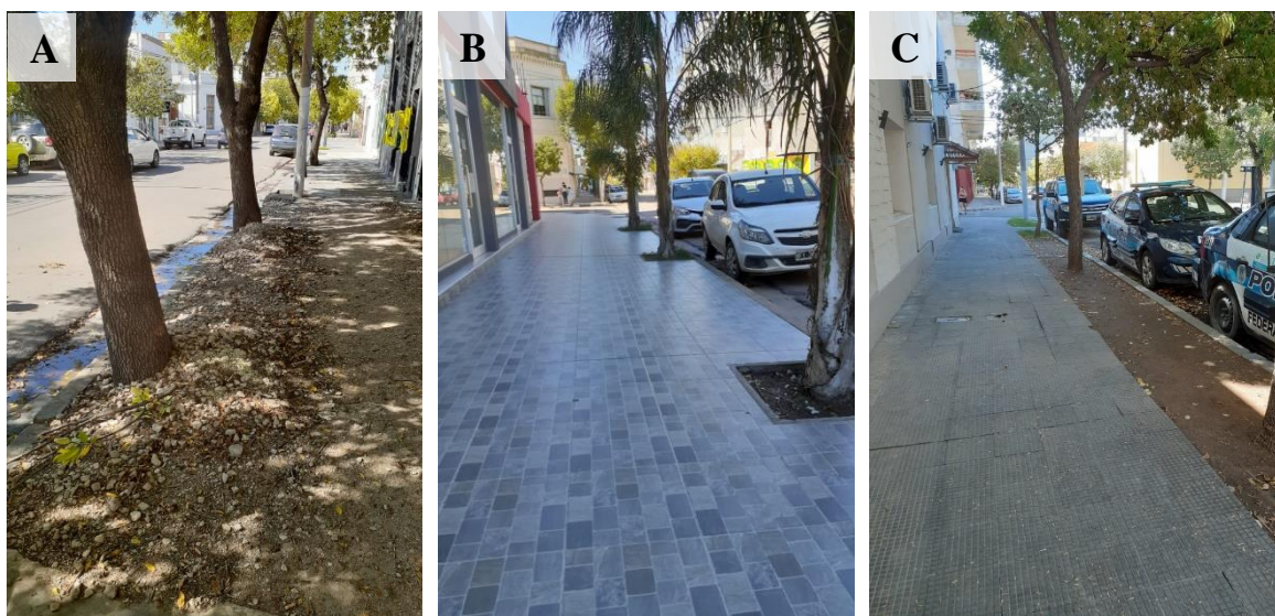
Figura 13. Tipos de vereda: A) vereda sin construir, B) vereda construida y C) vereda tipo jardín.
