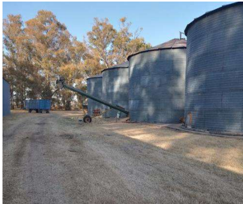
Figura N° 2. Vaciado de Silo de 300 tn con Transportador a Sin Fin Móvil - Planta de Acopio N° 2.
