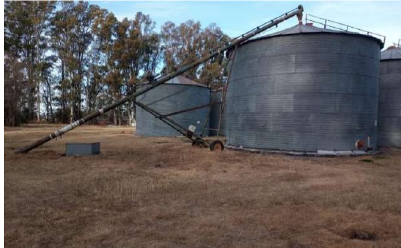
Figura N° 1. Llenado de Silo de 300 tn con Transportador a Sin Fin Móvil - Planta de Acopio N° 2.
