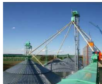
Figura N° 43. Cañerías de Descarga por Gravedad.
