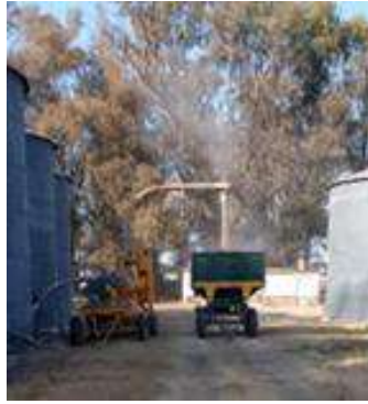
Figura N° 3. Limpieza de Fondo de Silo de 300 tn con TNP - Planta de Acopio N° 2.
