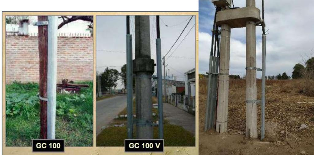
*Imagen 2.5.3-1: Guardacables gruben GC100 y GC 100 V*
