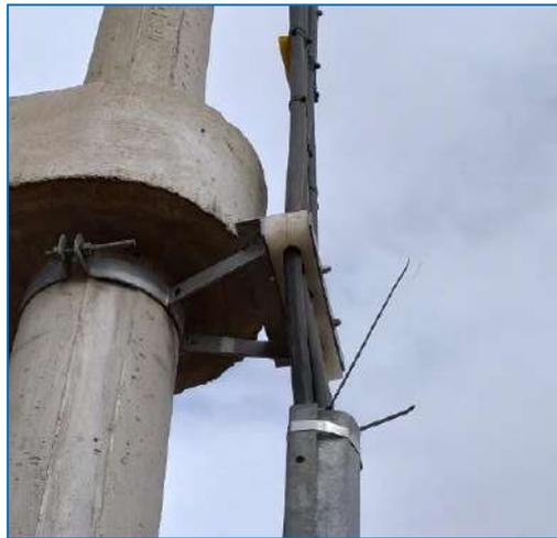
Imagen 2.5.3-2: Fijación del cable de media tensión subterráneo a la estructura
