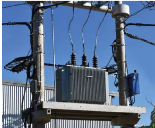
Figura 3 - Transformador de distribución. IRAM 2250
