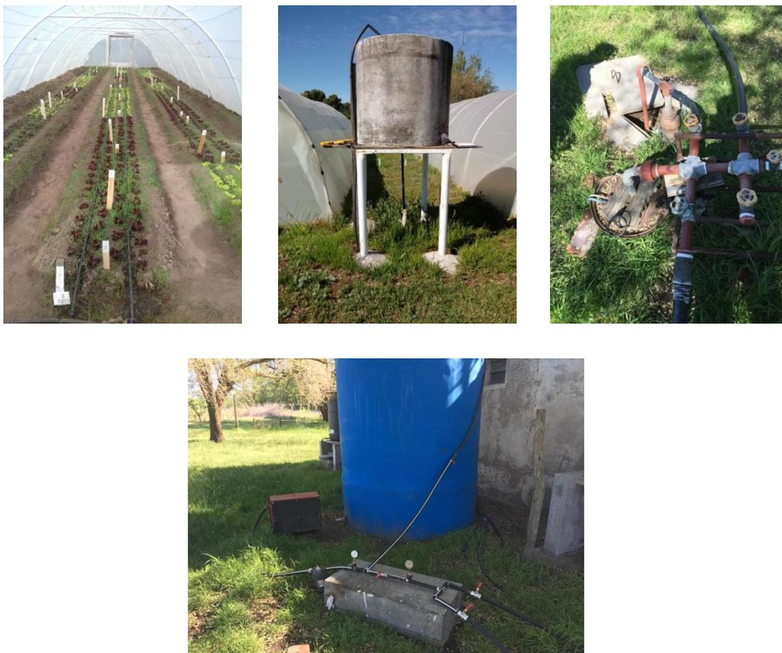
*Imagen 1: Fotografías tomadas en la huerta de la FA, puede verse el interior del invernáculo 3, el tanque elevado abastecedor de agua del invernáculo 2, la perforación junto a los distintos ramales de alimentación y el tanque para almacenaje de agua tratada por osmosis inversa junto con la bomba y el regulador de presión.*
