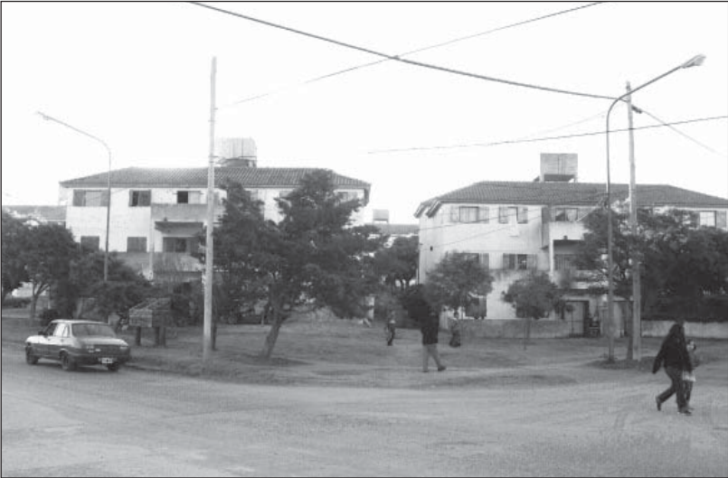
Figura 8. Viviendas de planees sociales sobre la calle Puerto Madryn.
