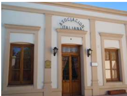
Referencia: Edificio de la Sociedad Italiana. Fotografía: Silvina Garbarino
