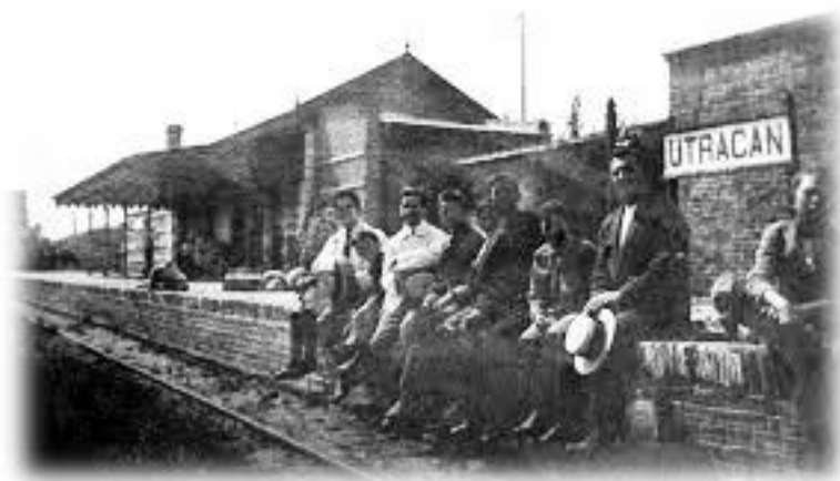
Referencia: Estación Utracán.
