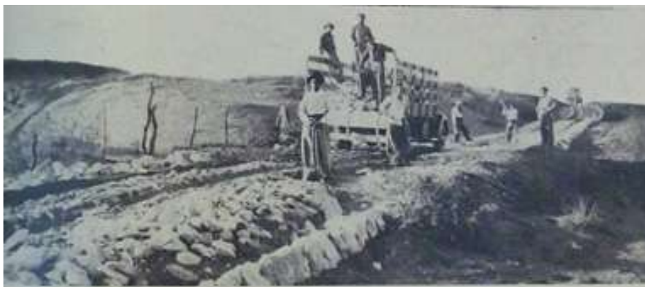
Referencia. Obra en construcción del Camino Acha – Utracán. La Moderna, 1939.
