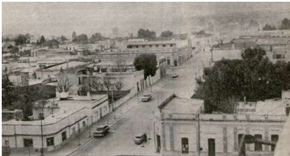
Referencia: Vista de una calle céntrica de General Acha. Al frente el edificio de la Oficina de Correos de la Nación. Fuente: Revista Proa . Año 1939.
