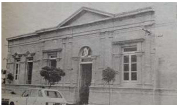
Referencia: Antigua sede del Municipio local. Calle Gral. Campos
