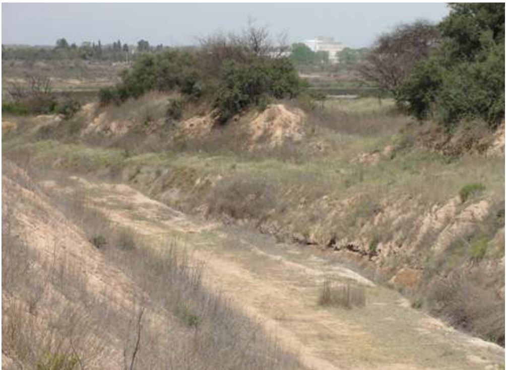
Referencia: Canal derivador de los excesos hídricos de la laguna Quetré Huitrú hacia el llamado “Bajo de Gamay”. Fuente: foto del autor
