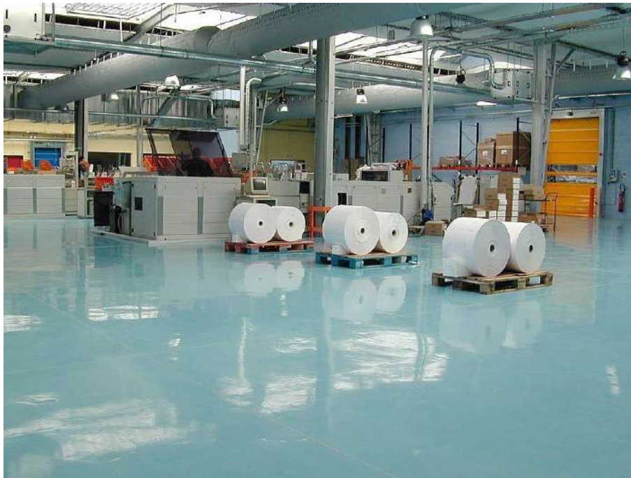
Imagen 16: Piso a base de poliuretano.
