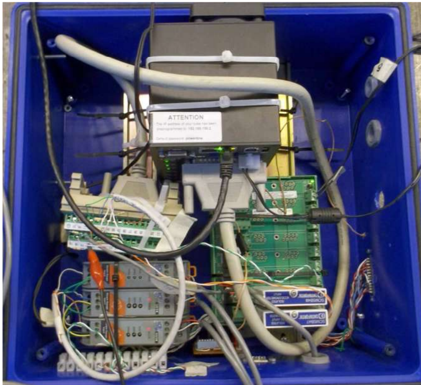
Figura 4.6: Gabinete con elementos del sistema de adquisición de datos.
