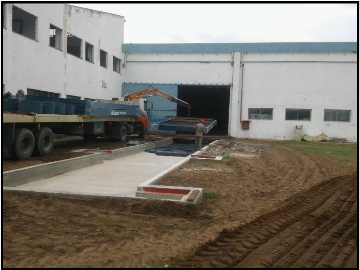
Fig.9: obra civil de la báscula.
