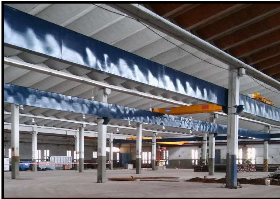
Fig.8: Puentes grúa instalados.
