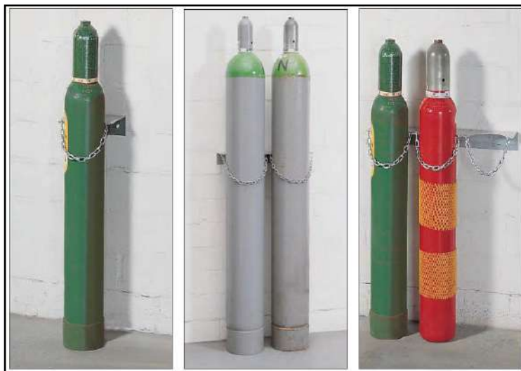
Figura 11. Tubos asegurados con cadenas.
