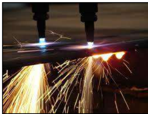
Figura 10. Trabajos en oxicorte y plasma.
