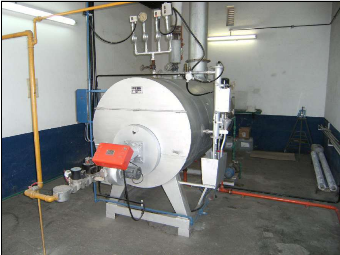
Figura 14: Caldera humo tubular IFI-ARAOZ de alto rendimiento.
