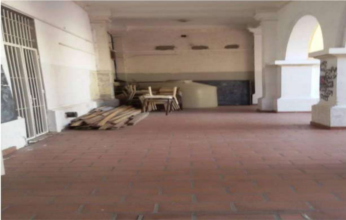
Patios y galerías Escuela Primaria N° 2.
