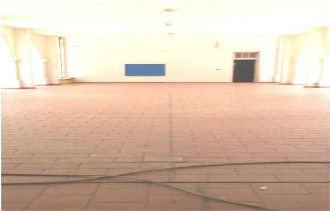
Patio cerrado y salón de usos múltiples de la Escuela Primaria N°2.
