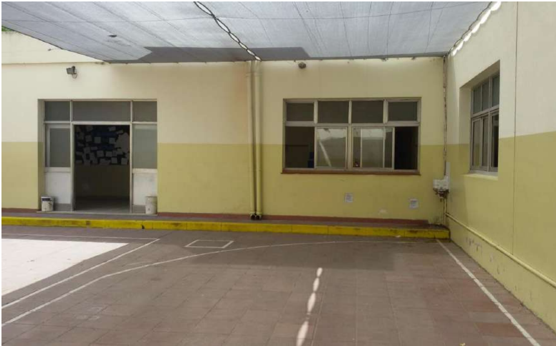
Patio Escuela Primaria N° 39.
