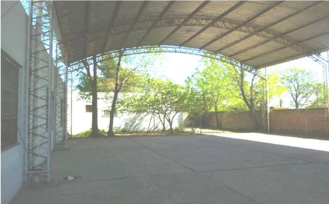
Patio semicubierto de Escuela Primaria N° 25.
