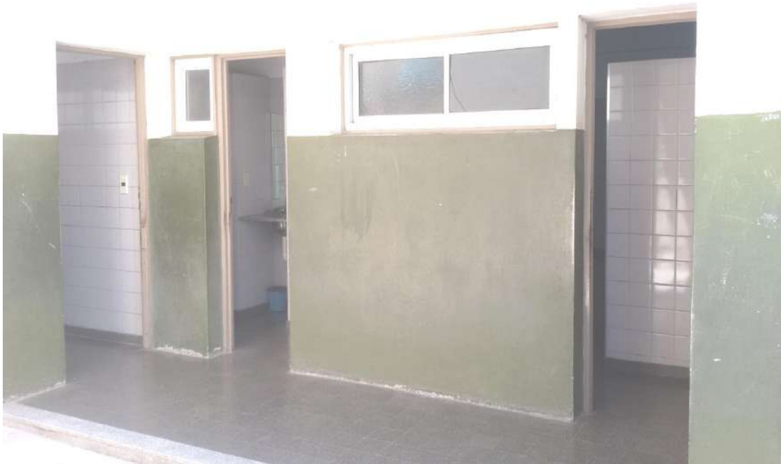
Sanitarios a compartir en la Escuela Primaria N° 12 y la Secundaria 308.
