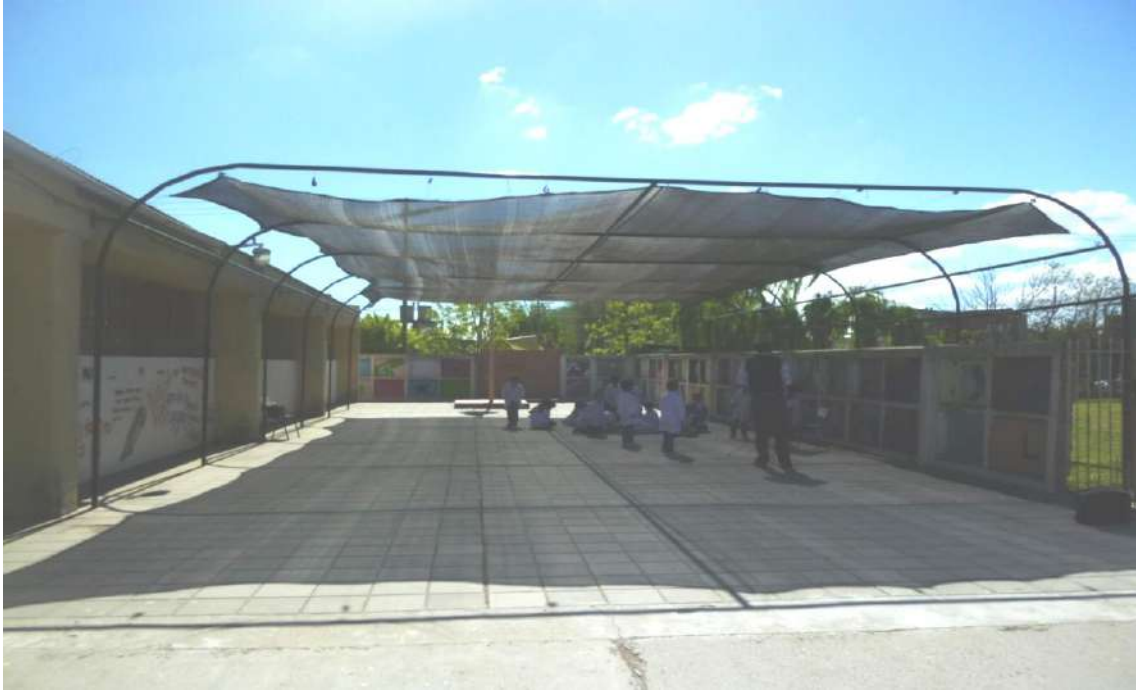
Patio Escuela Primaria N° 65.
