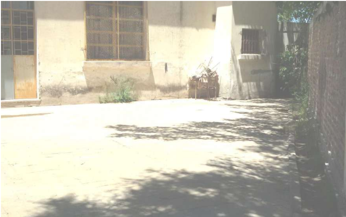
Patio de Escuela Primaria N° 23.
