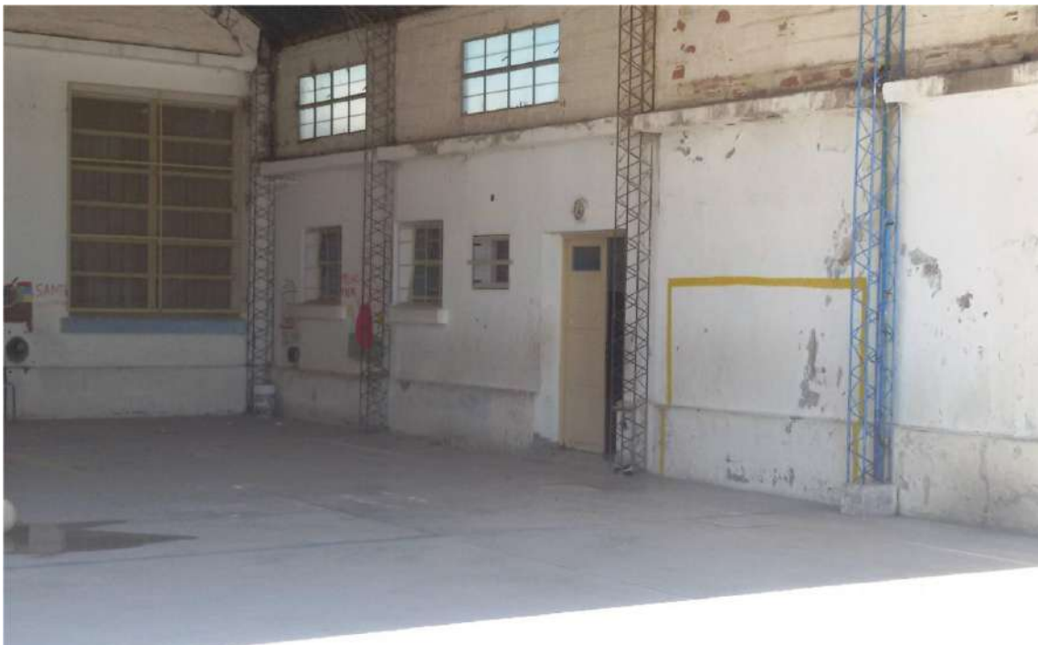
Patio Escuela Primaria N° 23.
