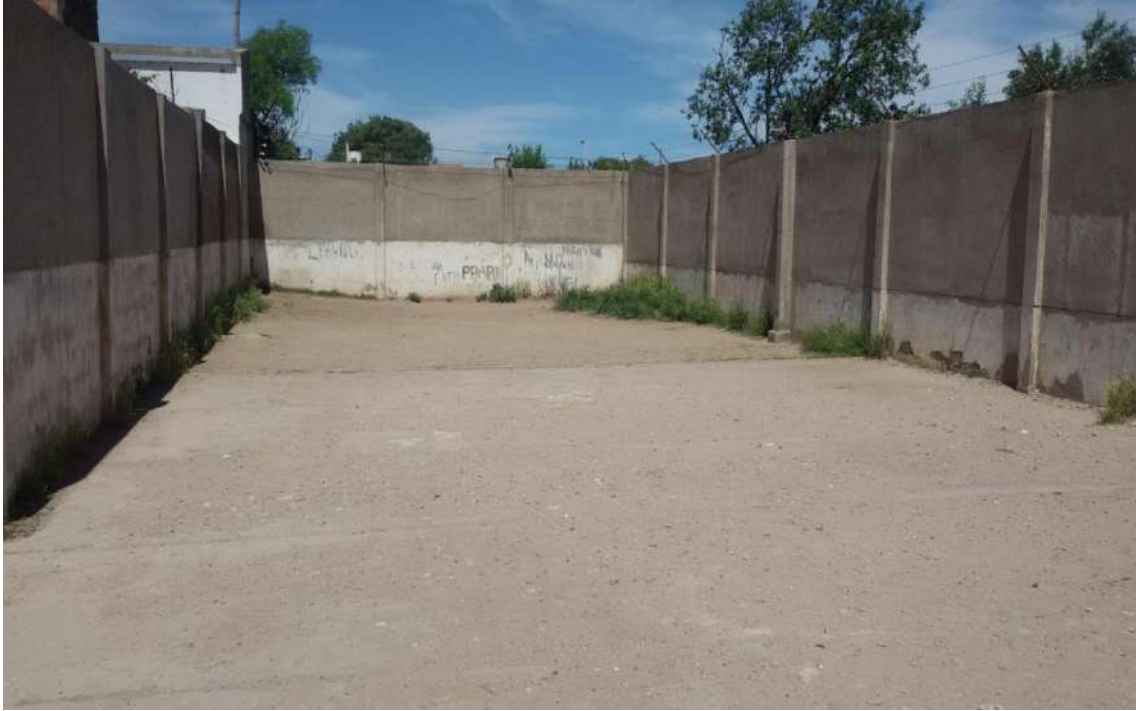
Patio Escuela Primaria N° 62.
