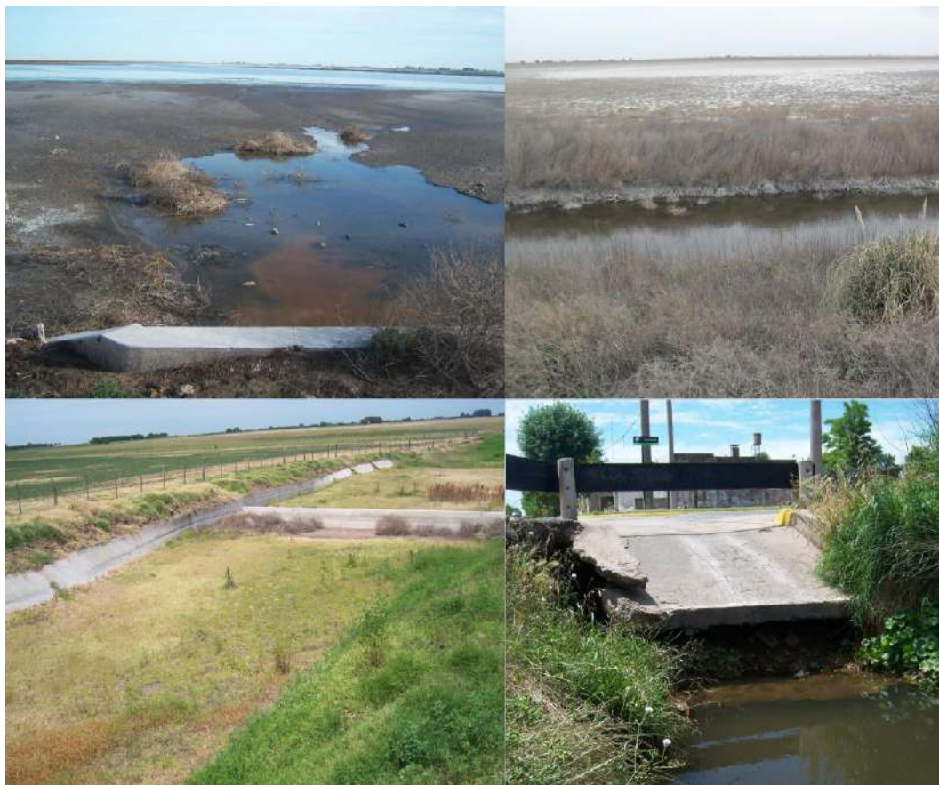
Figura A11. Efecto de la canalización sobre el anegamiento en zona urbana y rural.
