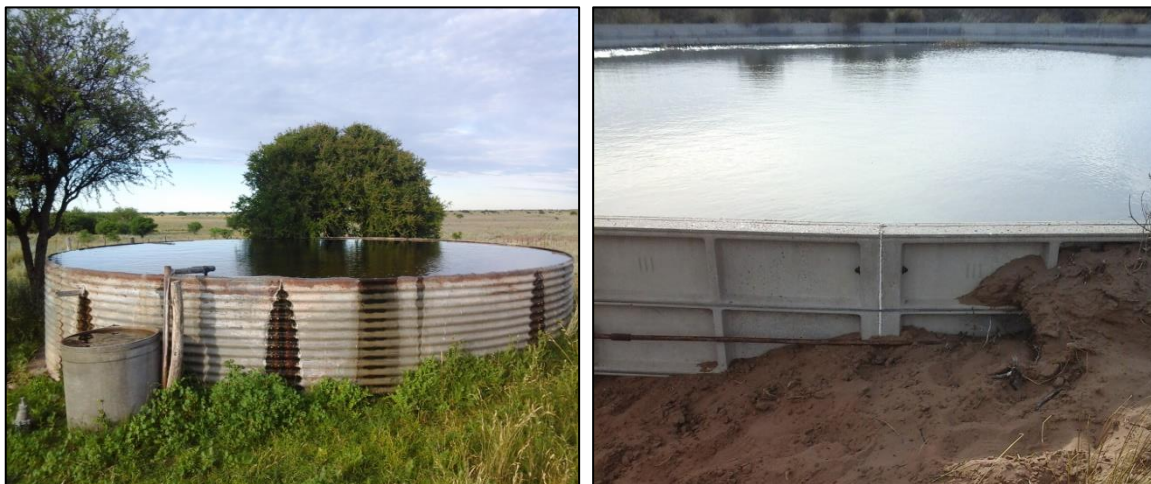
Figura 5. A la izquierda un tanque con terraplén bajo (distancia externa mayor a 30 cm) y a la derecha un tanque con terraplén alto (distancia externa menor a 30 cm).
