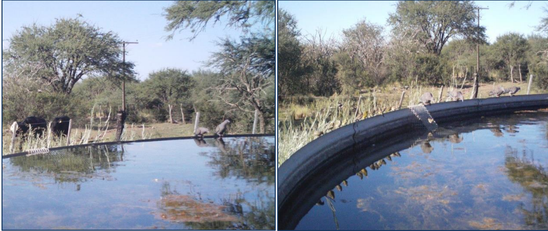
Figura 4. A la izquierda un tanque con nivel de agua alto (menor borde libre) y a la derecha un tanque con nivel de agua bajo (mayor borde libre).
