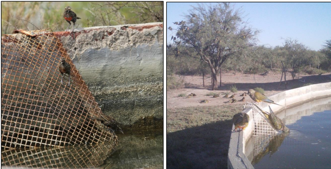
Figura 2. Malla de hierro aún sin plegar (a la izquierda) y rampa de rescate ya colocada en el reservorio de agua.
