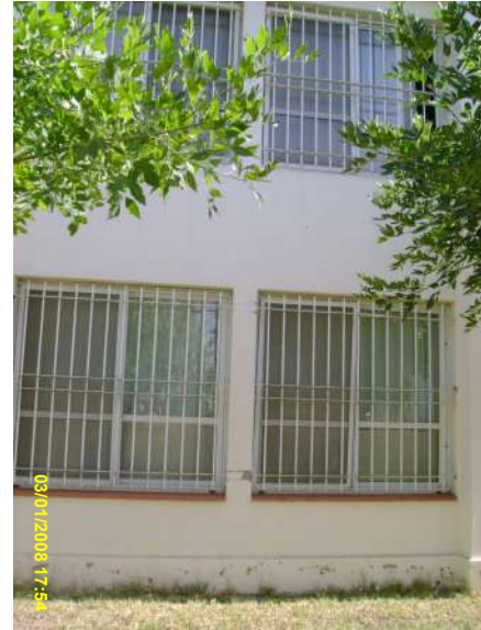
Fig. 3.9 – Vista frontal de las ventanas de los dormitorios de los departamentos 2 y 5
