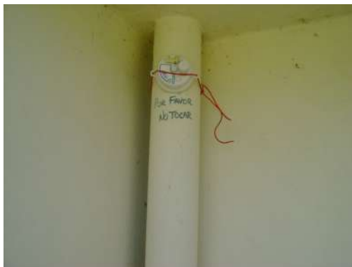
- Sensor ubicado en el Exterior
