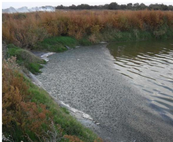
Figura N° 9: Acumulación de materia orgánica flotante procedente de las lagunas primarias en el sector de ingreso a la laguna N° 3.
