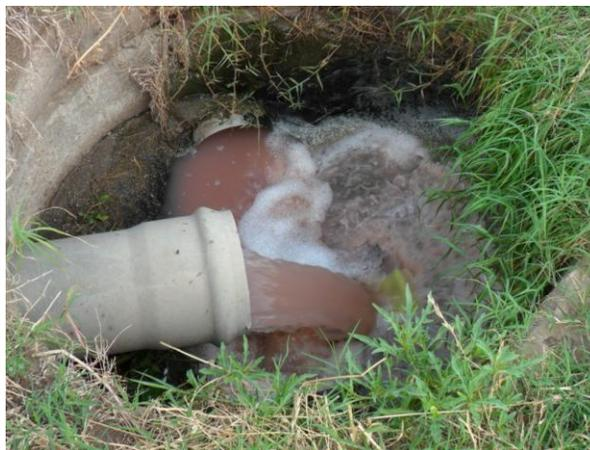
Figura N° 14: Coloración rosada correspondiente al efluente de las lagunas de tratamiento primario, fotografiadas en el mes de diciembre de 2013.
