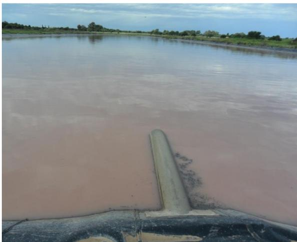
Figura N° 8: Salida de la laguna primaria N°2 dispuesta sobre el pelo de agua y con materia orgánica a su alrededor.
