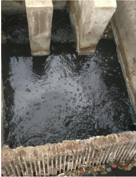
Figura N° 11: Agua residual sin tratamiento contenida en la cámara partidora, con coloración y consistencia diferentes al ARU.
