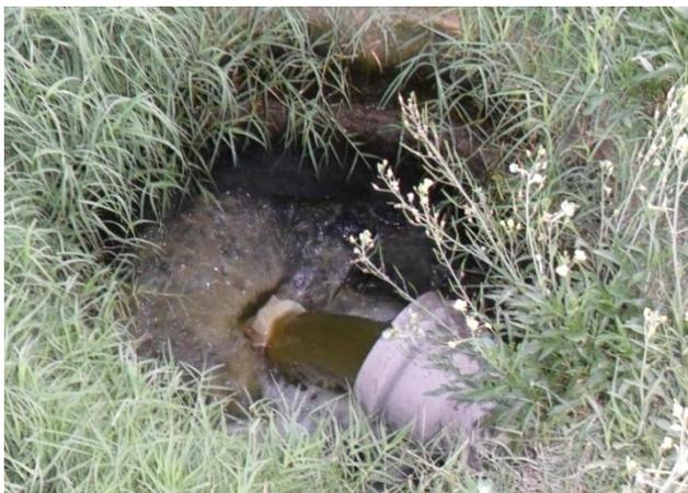
Figura N° 13: Coloración verdosa del efluente de las lagunas de tratamiento primario durante el mes de marzo de 2013.
