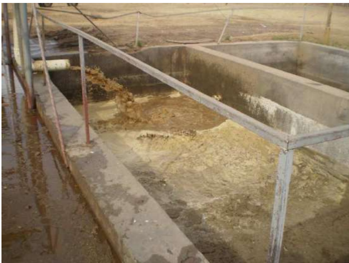
Fotografía 6. Segunda pileta de decantación por donde pasan los efluentes luego de haber pasado por el tamiz.
