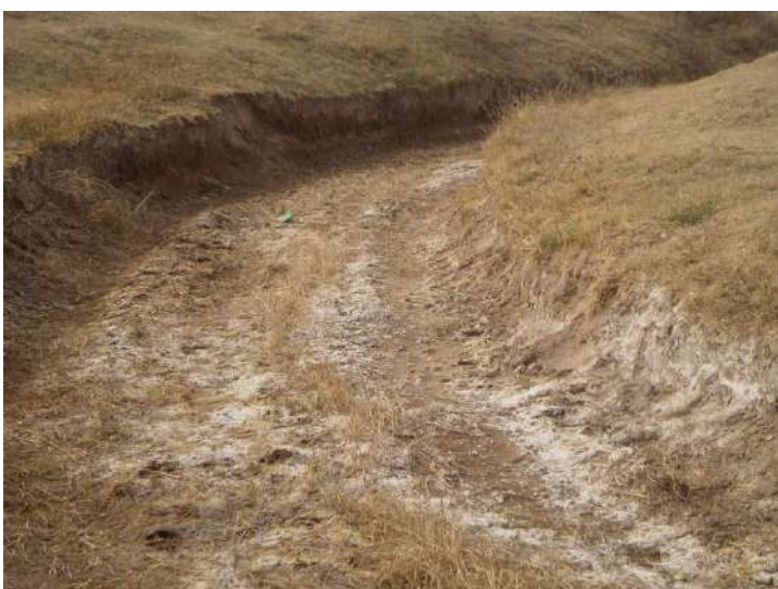
Fotografía 17. Parte del canal derivador a cielo abierto de la laguna “La Peluda”, la cual se encuentra seca desde varios años. A pesar de esto, se puede observar suelo hidromorfo y con presencia de salinización.
