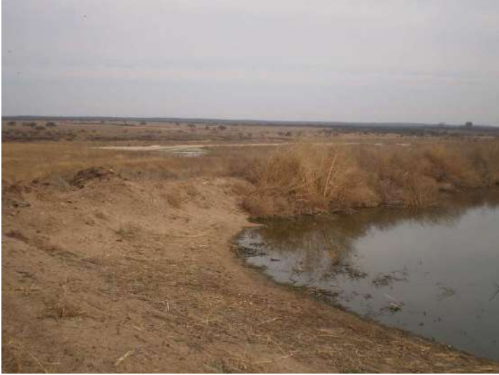
Fotografía 10. Se observa la segunda pileta de oxidación en primer plano y en segundo plano se puede observar la acumulación de líquido en el bajo producto de la filtración de esta pileta.
