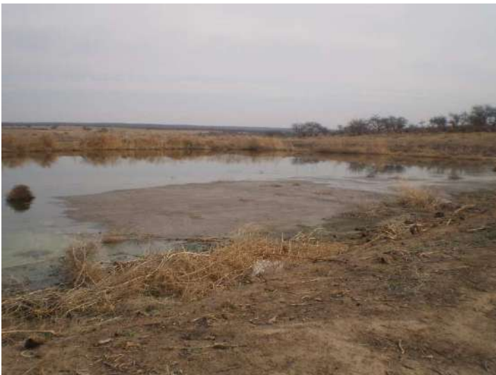
Fotografía 8. Segunda pileta de oxidación a cielo abierto.
