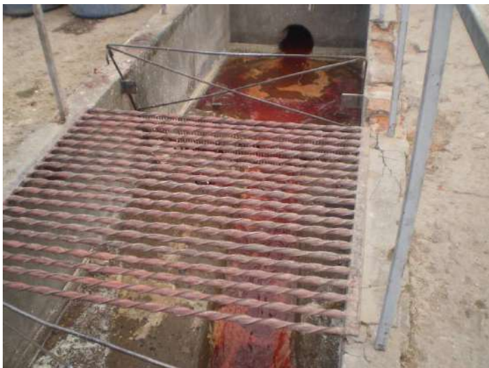
Fotografía 2. Fin de la canalización de aguas de uso industrial. En el momento de la toma de la fotografía se estaba realizando la limpieza de los pisos.
