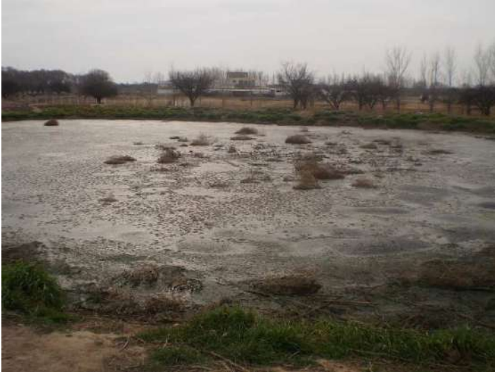
Fotografía 7. Primera pileta de oxidación a cielo abierto.
