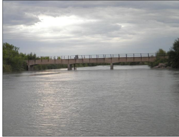
Figura 3.12: Estación de Aforo “Paso La Arena”.
