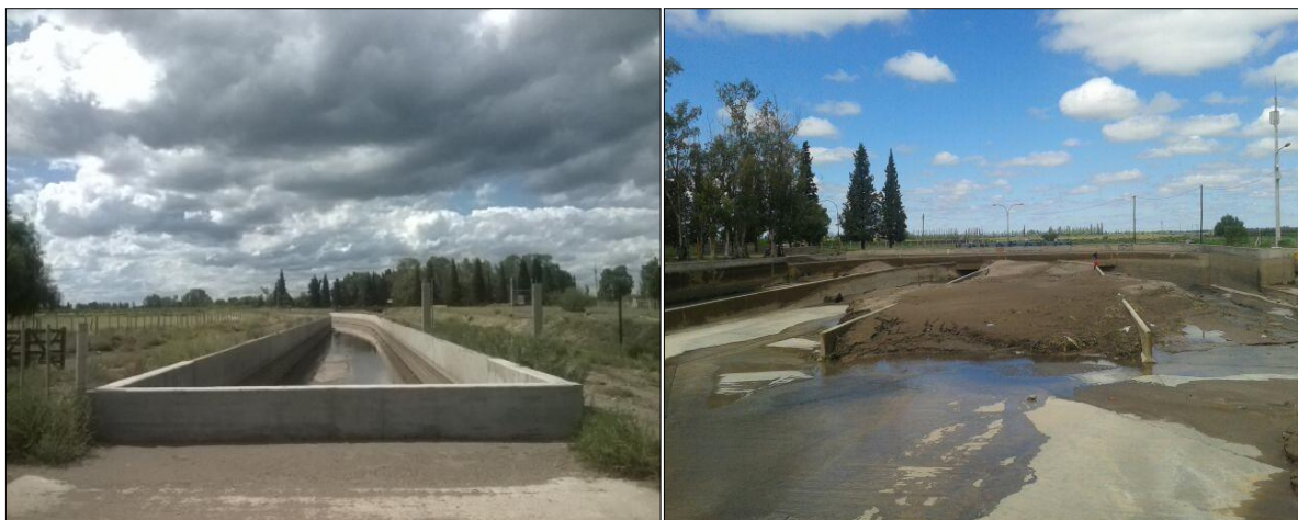
Figura 3.6: Canal Matriz Nuevo Alvear y Dique Desarenador “La Olla”
