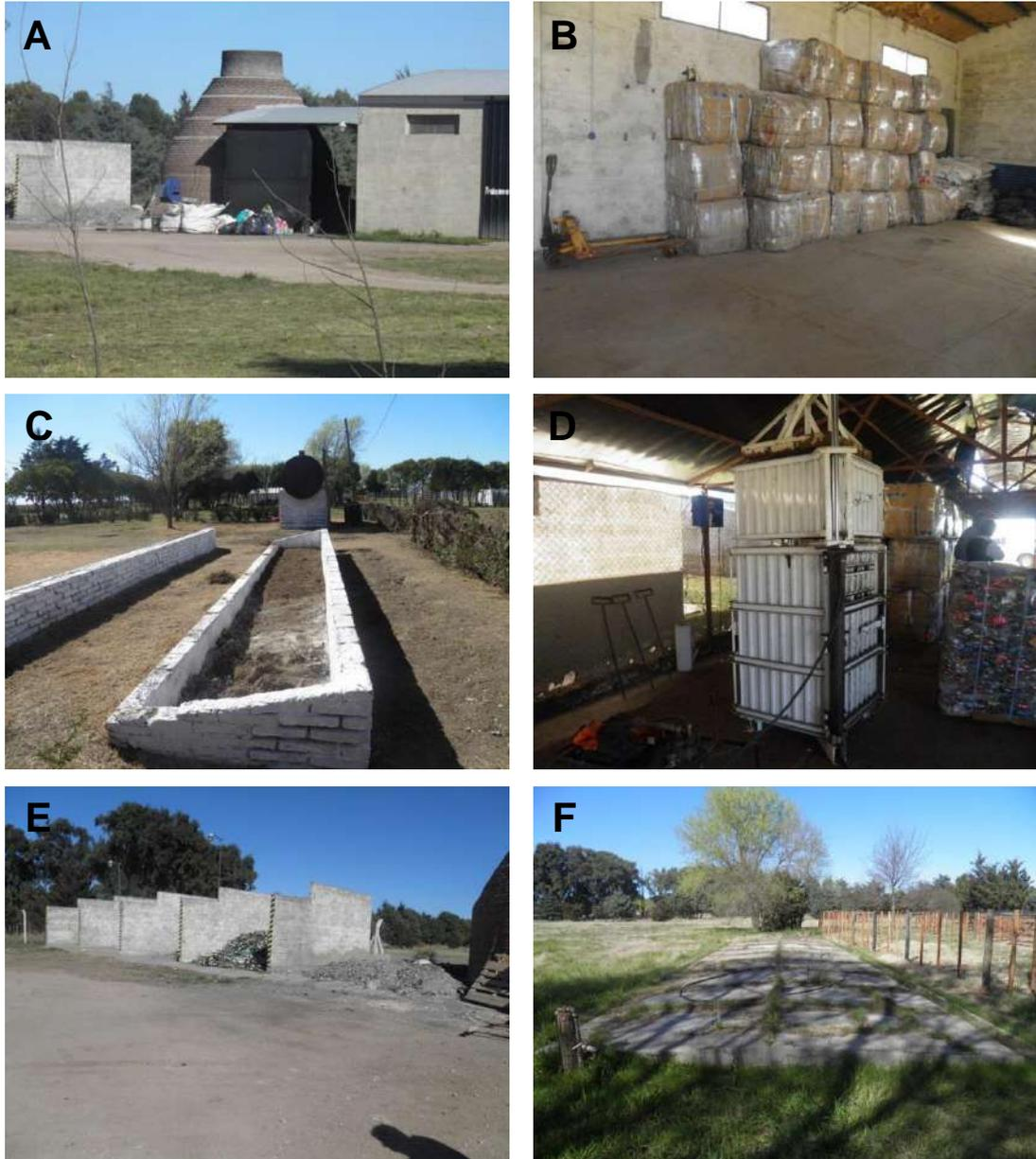
**Figura 39.** Sitio de disposición final en Gral. San Martín, La Pampa. **A:** Horno pirolítico; **B:** Acopio de materiales recuperados; **C:** Camas de compostajes; **D:** Prensa Hidráulica; **E:** Boxes de acopio; **F:** Platea para futura ampliación de planta. Junio 2016.
