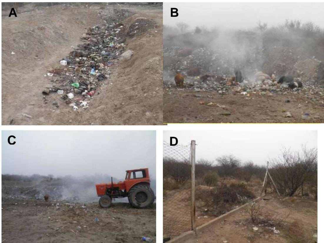
**Figura 21.** Sitio de disposición final en Santa Isabel, La Pampa.; **A:** Cava de disposición final; **B:** quema de RSU, observándose la presencia de animales domésticos alimentándose; **C:** enterramiento de RSU; **D:** roturas del alambrado perimetral. Junio 2016.
