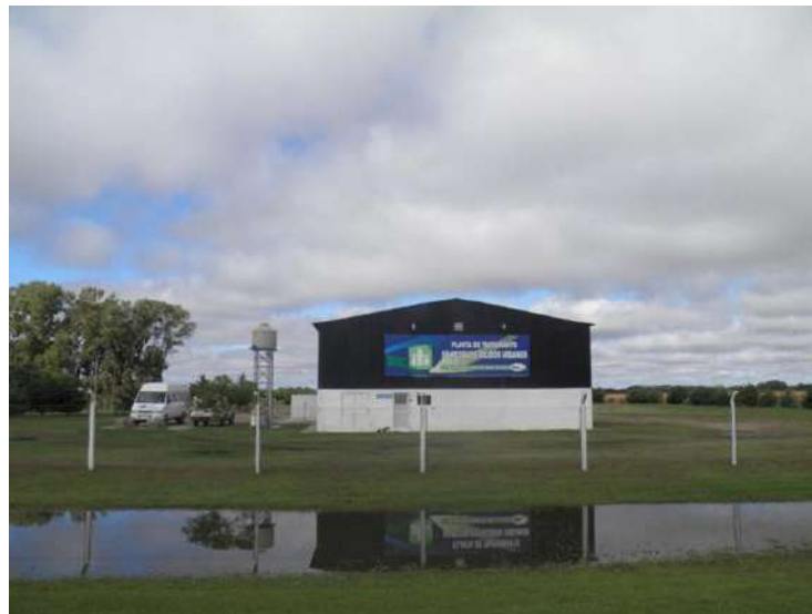
Figura 26. Planta de Tratamiento RSU. Municipio de Ingeniero Luiggi (Fuente: Subsecretaria de Ambiente).
