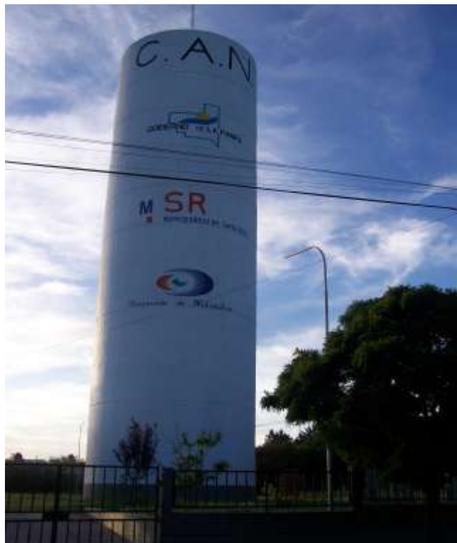
Foto 8: Centro de Abastecimiento Norte
