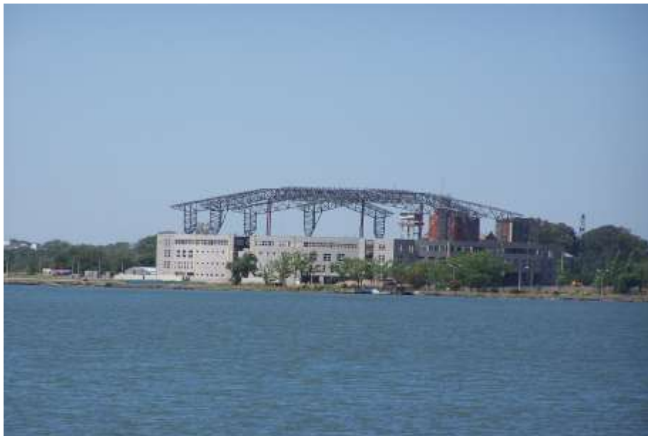
Foto 4: Estructura de Estadio provincial en el predio de Laguna Don Tomás
