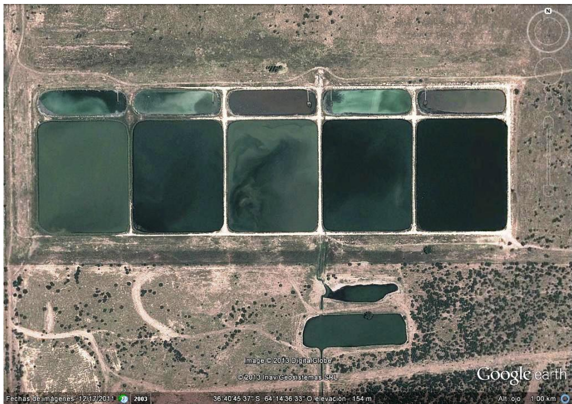
Figura 8: Imagen satelital de la planta sur de tratamiento de residuos cloacales de Santa Rosa (tomado de Google Earth 17/12/2011).
