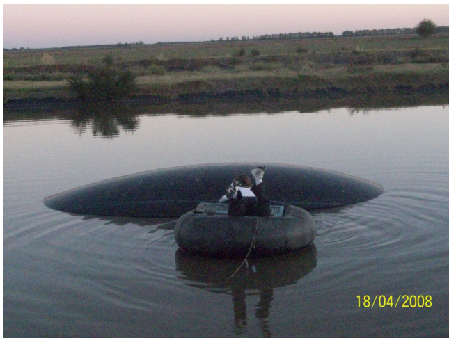
Fotografía 8: Membrana impermeabilizante rota generó en la primer pileta un globo o “lomo de ballena” producto de la infiltración de líquido al suelo y la acción de bacterias degradadoras de la materia orgánica (pileta N°1)
