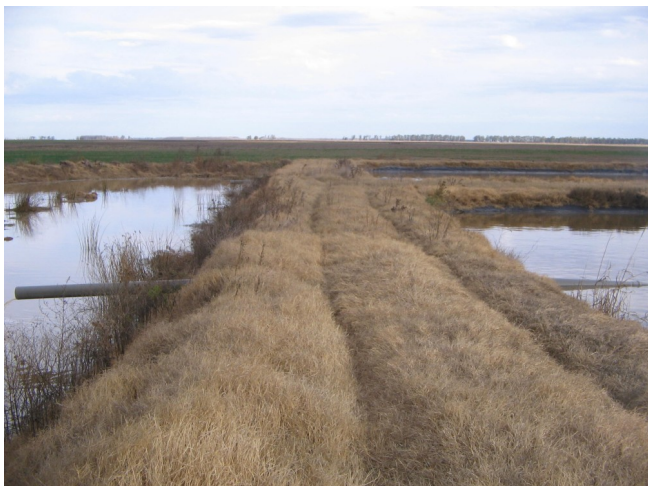
Fotografía 14: Salida de líquido desde la pileta N° 1 al canal que colecta el líquido tratado de ambas piletas y las dirige hacia su deposición final.
