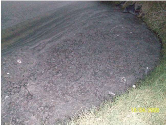
Fotografía 12: Formación de flóculos a orilla de la pileta N° 1, aparentemente por cortocircuito hidráulicos Determinados por la relación entre sus dimensiones a fin de homogenizar las condiciones del mismo.
