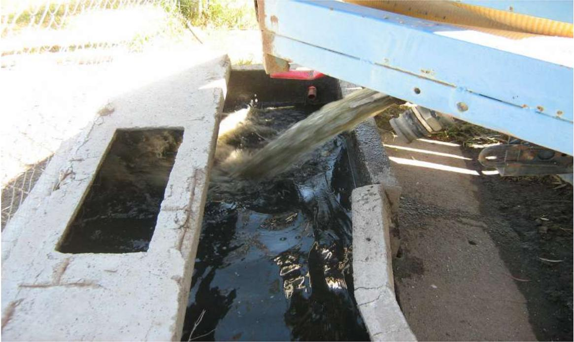
**Fotografía 18.** Descarga de un camión en la fosa decantadora.
