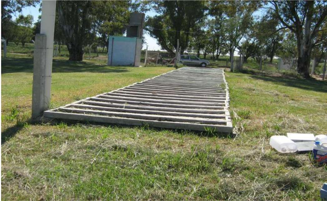
**Figura 14.** Vista de la fosa decantadora.
