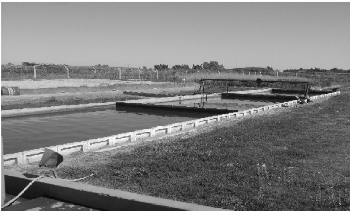
**Figura 4.** Cámara de Pre-Tratamiento o Sedimentación.
