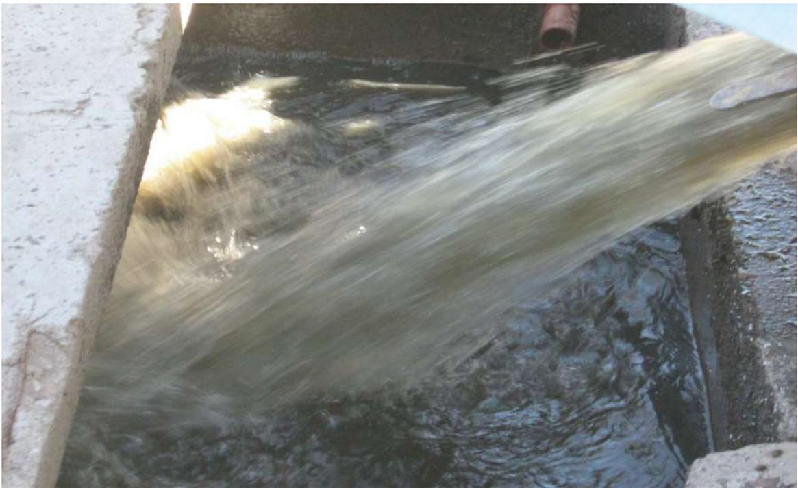
**Fotografía 19.** Descarga de un camión en la fosa decantadora.
