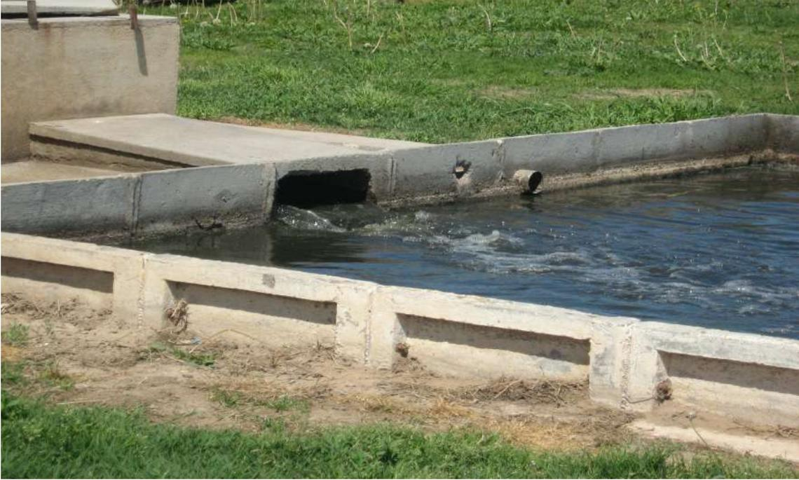
**Figura 8.** Entrada del efluente a la Cámara de Pre-Tratamiento.
