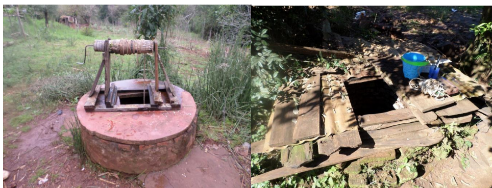
Figura 2.9. Pozos artesanales de extracción de agua del acuífero somero, para consumo humano.
