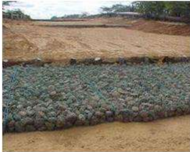
Figura 5.4. Colchonetas de gavión con recubrimiento de PVC (Villamarin Paredes, 2013).
