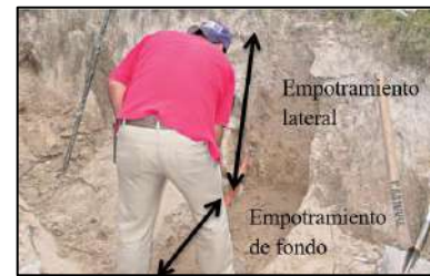
Figura 5.10. Empotramiento de la obra (Cardoza Vázquez et al., 2007).
