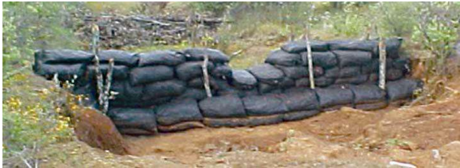
Figura 5.18. Barrera de geocostales con el refuerzo de estacas (Cardoza Vázquez et al., 2007).
