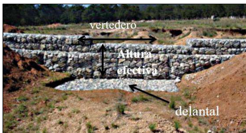
Figura 5.11. Elementos de diseño de las estructuras (Cardoza Vázquez et al., 2007).
