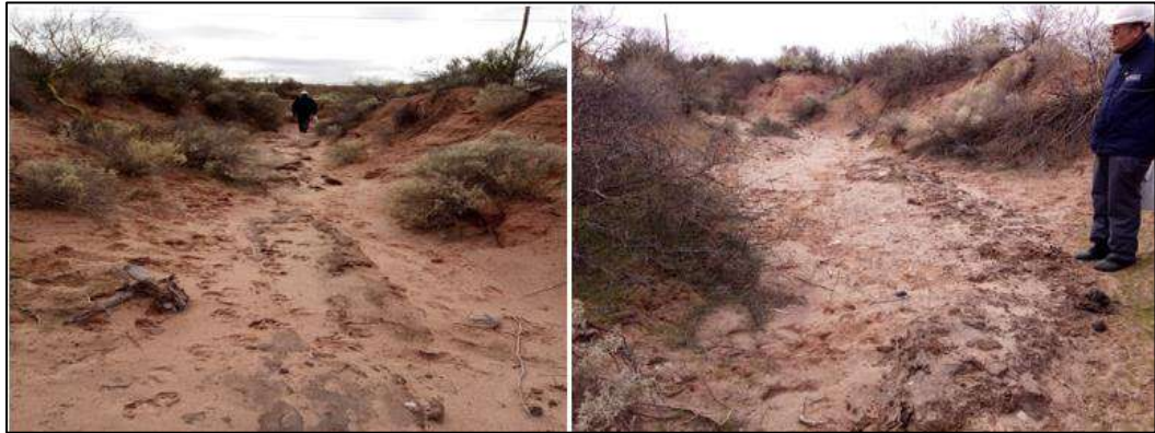
Figura 6.26. Costra de hidrocarburos en el piso de la cárcava.
