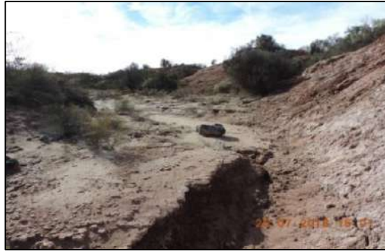
Figura 6.2. Arrastre de rocas de las defensas de basalto.
