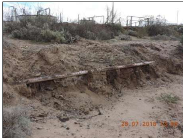
Figura 6.17. Línea de conducción del inyector destapada.
