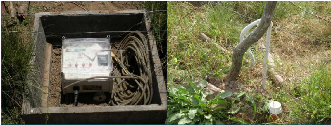
Figura A2. Aparato registrador del limnígrafo instalado y sensor de tensión del suelo Watermark.
