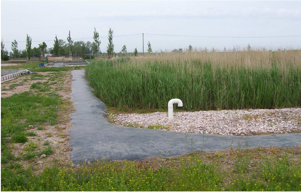
Figura 3: Filtro Fitoterrestre construído con Geomembrana de PVC (Otoño de 2007).
