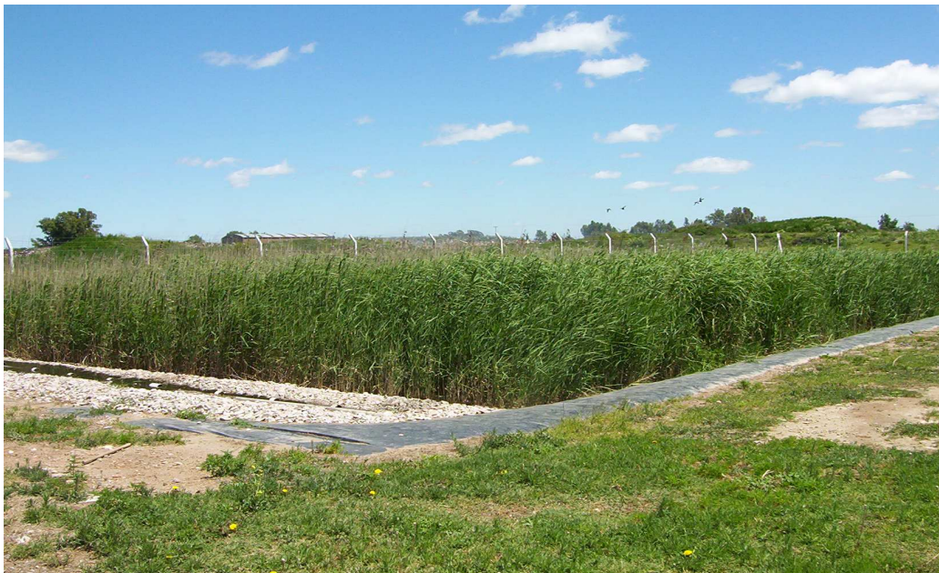
Figura 4: Filtro Fitoterrestre construído con Geomembrana de PVC (Primavera de 2007)
