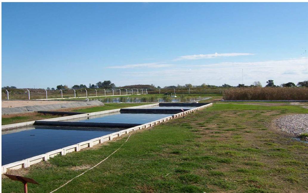
Figura 1: Cámara de Pretratamiento (vista lateral) Año 2006.
