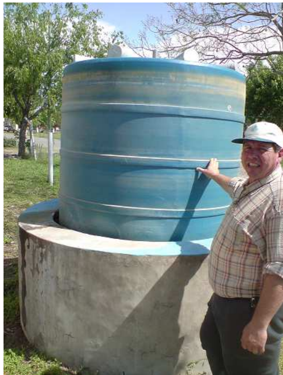
Figura 6: Gasómetro. Lugar de almacenamiento del biogás.
