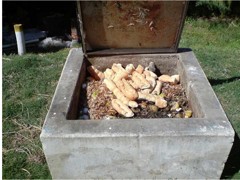
Figura 1: Cámara de Carga. Acá se colocan los desechos orgánicos para ser tratados dentro del biodigestor.
