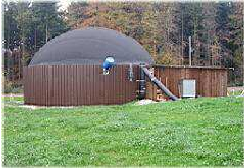
Biodigestor de tanque tradicional y cúpula de polietileno. Fuente: Fundación Hábitat.
