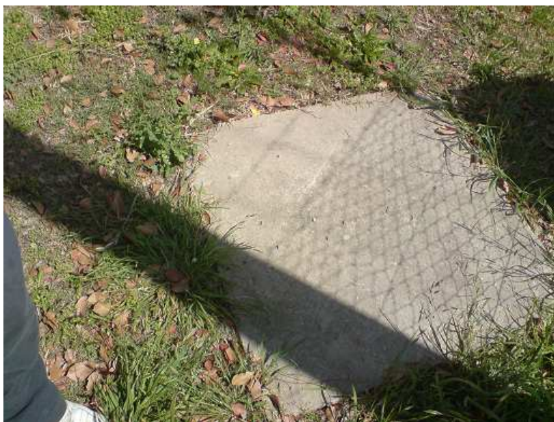
Figura 7: Cámara que une el caño que trae biogás del biodigestor, el caño que va al gasómetro y el caño de salida de biogás hacia la cocina.
