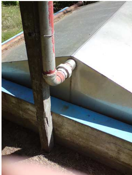
Figuras 3 y 4: Vista de la cámara de digestión y del caño de salida del biogas desde la cámara.
