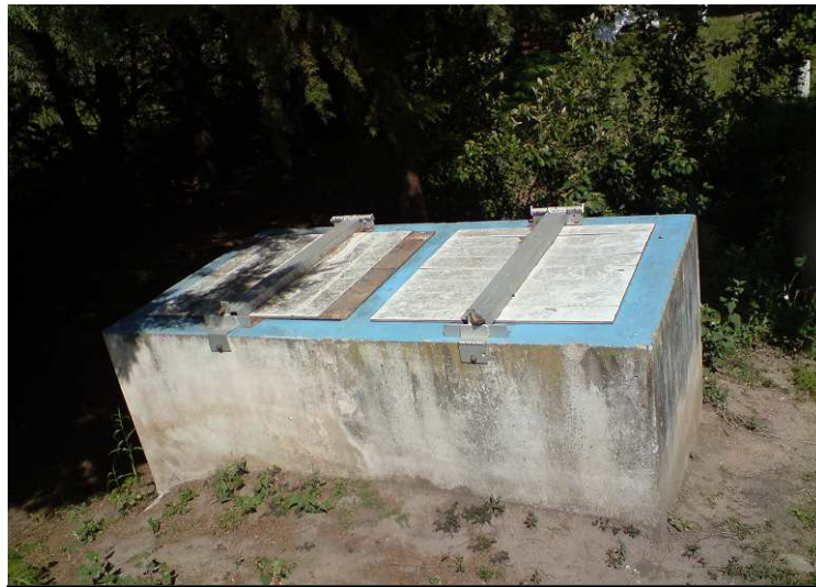
Figura 5: Cámara de descarga. Acá llegan los residuos ya tratados (abono orgánico).
