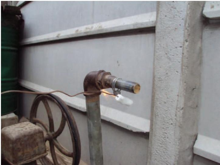
**Foto 8.** Esterilización de la salida de la cañería.
