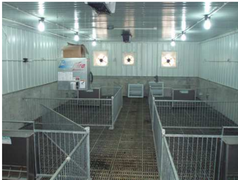
Foto 4: instalaciones de cerdos en recría.
