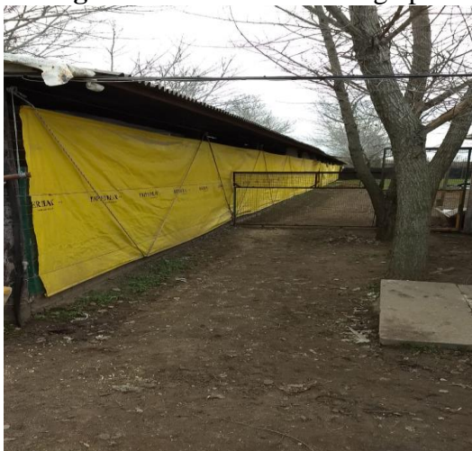
Fotografía 3: Vista lateral del galpón.
