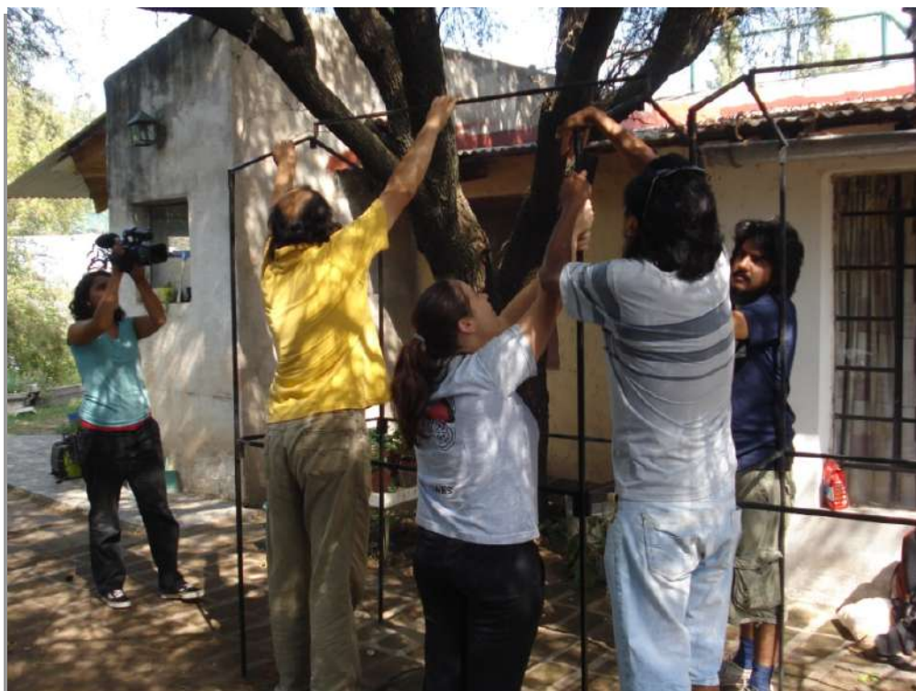
Minga para la construcción de puestos
