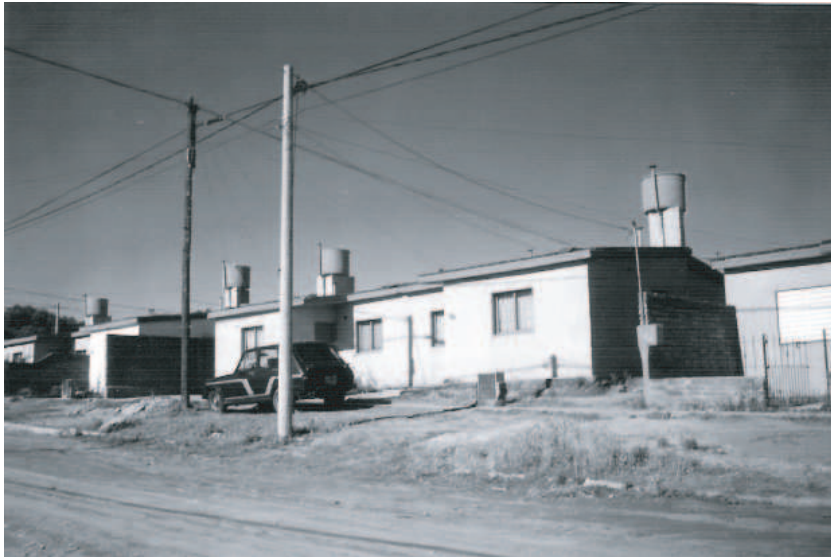
Fotografía N° 11.5. Barrio FONAVI XLV - Categoría Terminación Mínima - FOTO de las autoras Noviembre de 1998.
