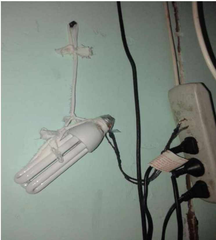
Inadecuadas instalaciones para brindar luz eléctrica.
