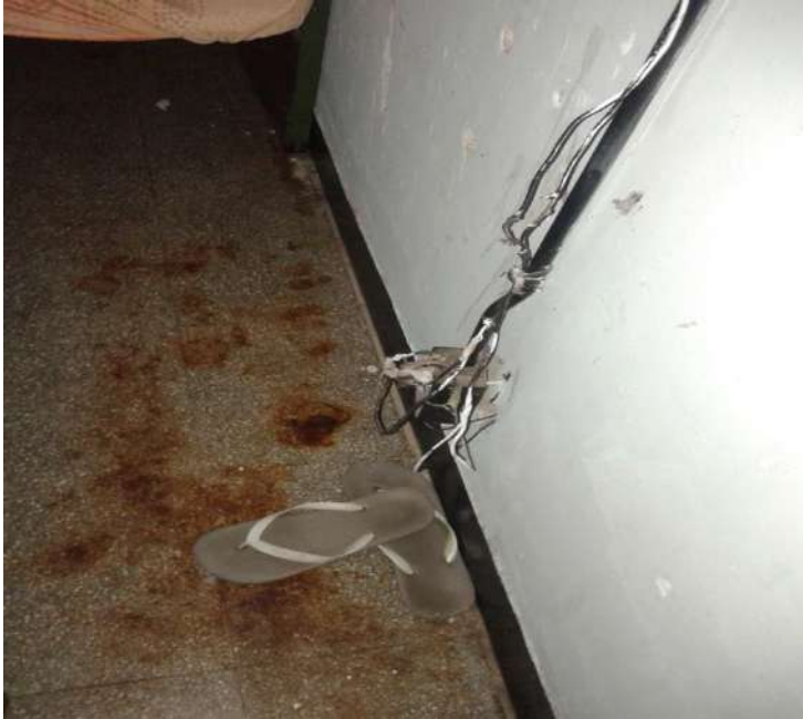
Inadecuadas instalaciones para brindar luz eléctrica.
