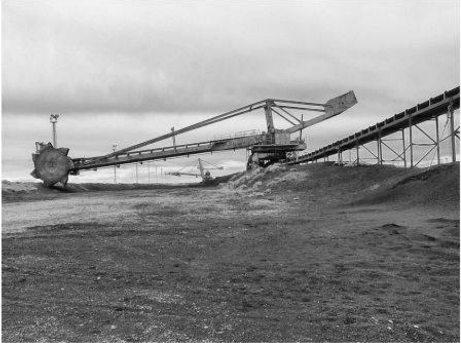
Figura 28: Infraestructura abandonada de YCF para la carga de carbón
