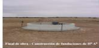
Final de obra - Construcción de fundaciones de 10' x 10'
