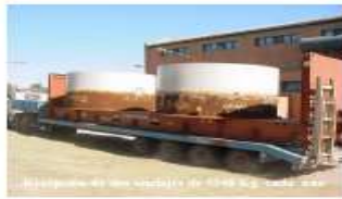
Recepción de los anclajes de 5200 kg.
