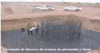
Armadura de fierros de trazo de pirámide y base
