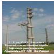
L. E. 33 KV. Estructura de Suspensión
