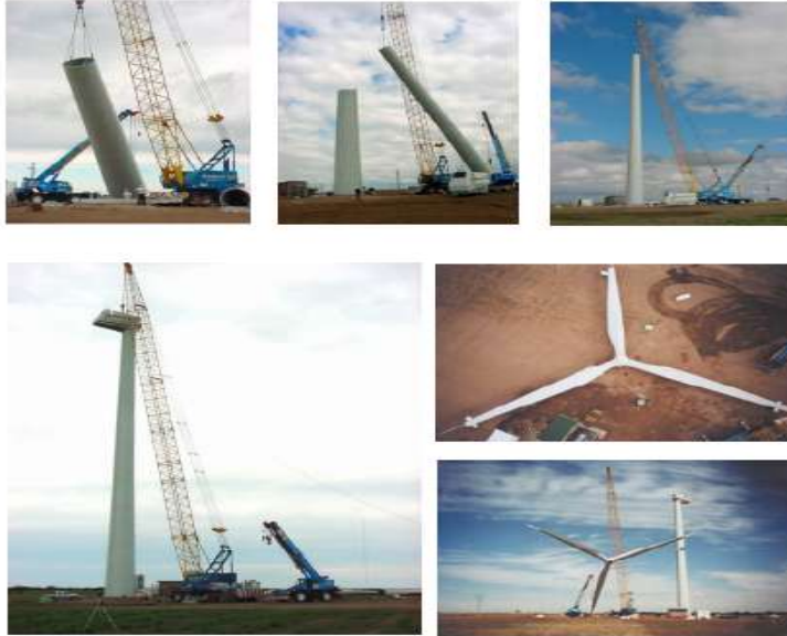
Proyecto Parque Eólico General Acha - La Pampa Ensamble y Montaje de Turbinas Eólicas NM 52/900-49
