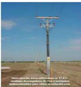
L. E. en 33 KV. Espectera Terrestre con accesorios tipo línea aérea para insulso. Armadura ST. AEP (La Pampa)
