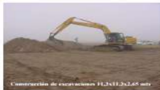
Construcción de excavaciones 11,2x11,2x2,65 mts
