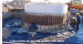
Colocación de insulso dentro del fuste
